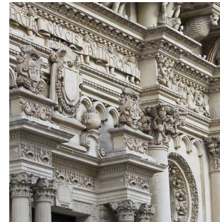
Basilique Santa Croce de Lecce en Italie (1695) - Façade - Architecture baroque -
